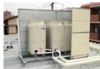
店舗折板屋根設置
