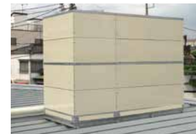
店舗折板屋根設置
