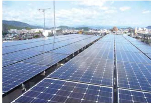
約27kW 4段12列横置、3段12列横置、5段4列横置、5段2列横置5°
