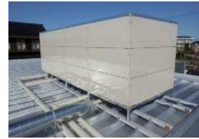
店舗折板屋根設置
