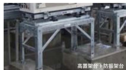
高置架台+防振架台
